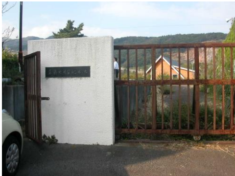
写真－7 用留配水池（1）
