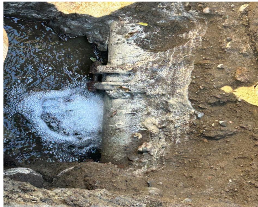
【令和6年 配水管漏水】 真鶴字山下地内漏水（県道739号線）
