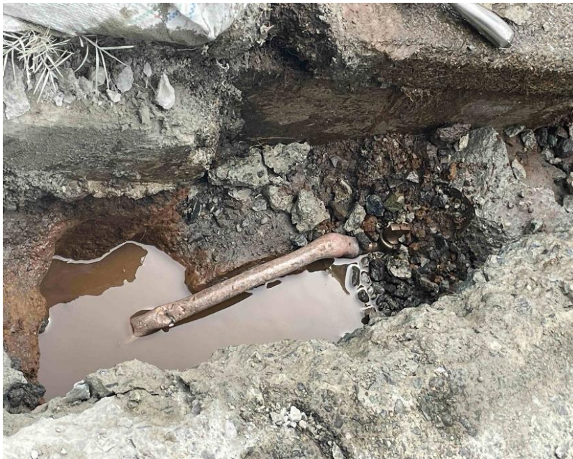
【令和7年 給水管漏水】 真鶴字狐塚地内漏水（町道真第567号線）
