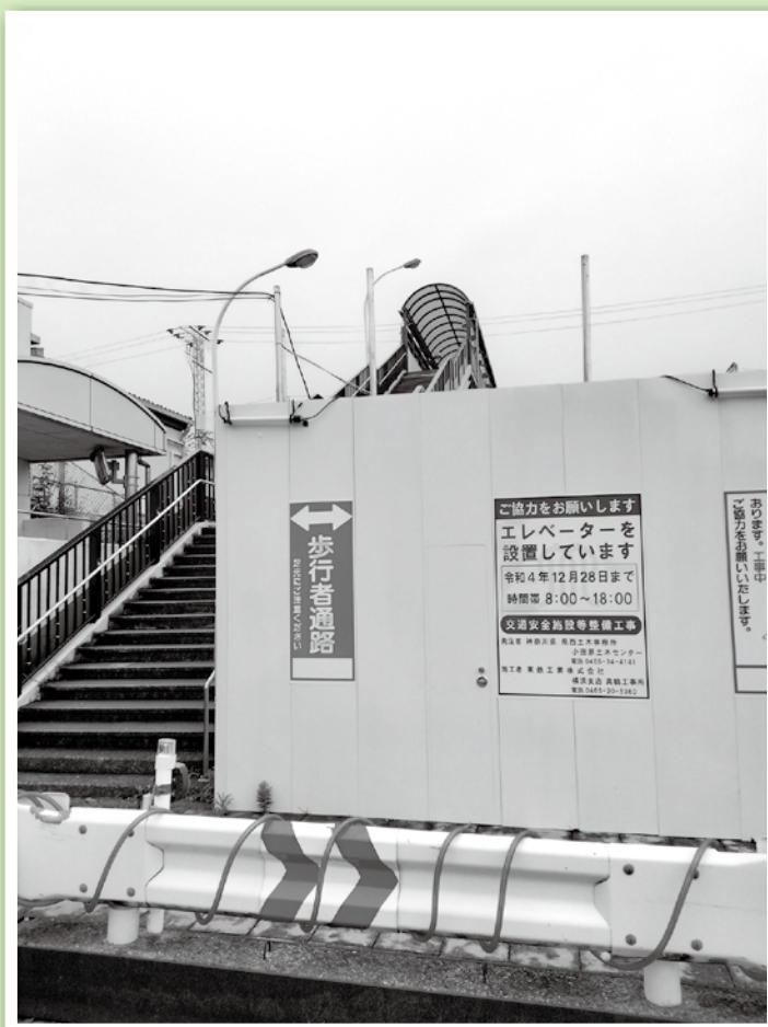
真鶴駅跨線橋南側エレベーター 設置工事
