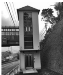
跨線橋エレベーター
