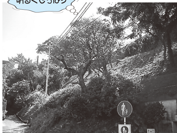
工事が半分修了した現場 H22・7・18 撮影
