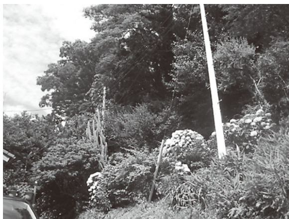
工事着手前の状況 H22・6・5 撮影
