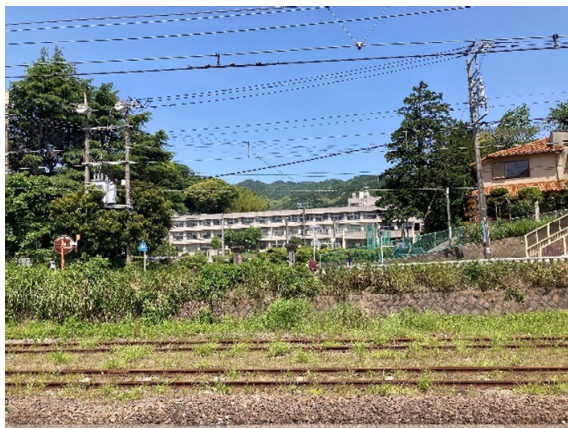
○真鶴駅ホームからの校舎外観
