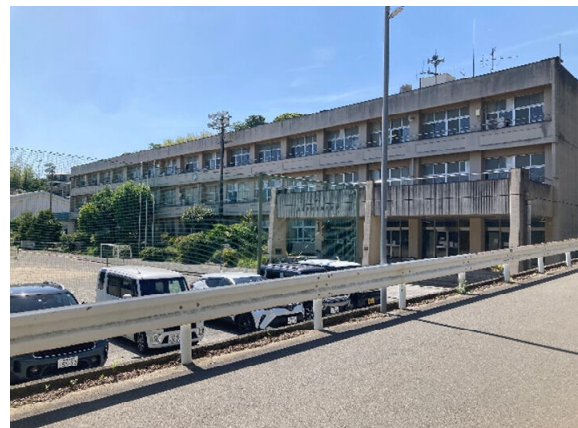
○校舎全景（東側道路からの全景）
