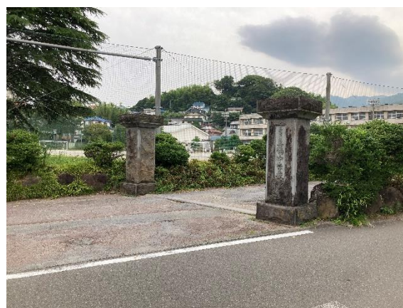
②南東側の正門まわり
