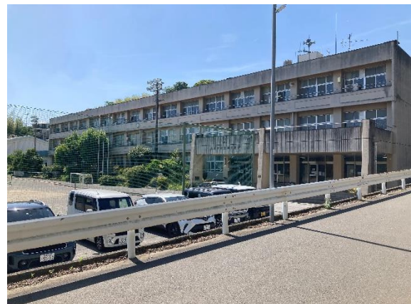
○校舎全景（東側道路からの全景）
