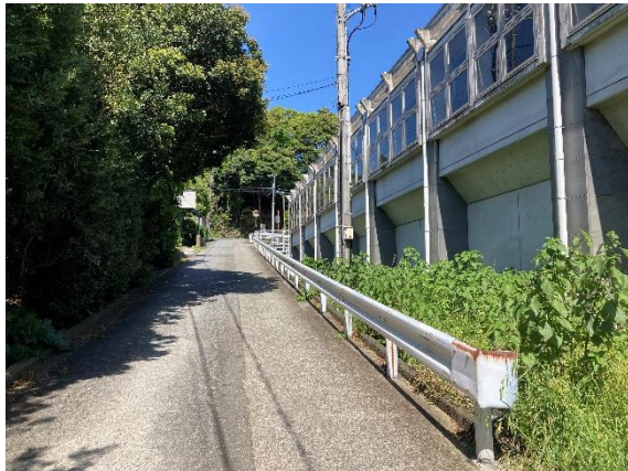
⑦北側道路との関係（町立体育館付近）
