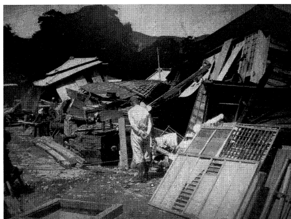
関東大震災により倒壊した家屋
