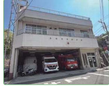
⑨ 湯河原町消防署真鶴分署
