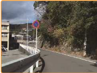
ほどう ガードレールと歩道
