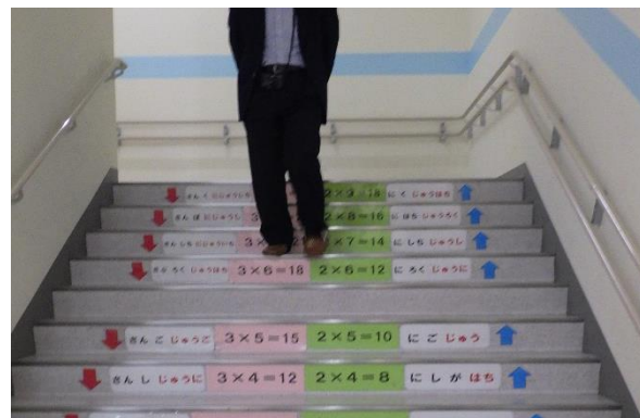
◆低学年に合わせた階段幅と二段組の手すり
