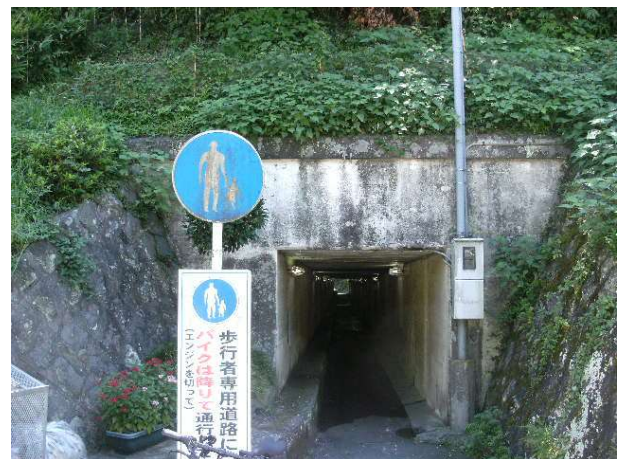
第2東前沢トンネル 終点(山側)
