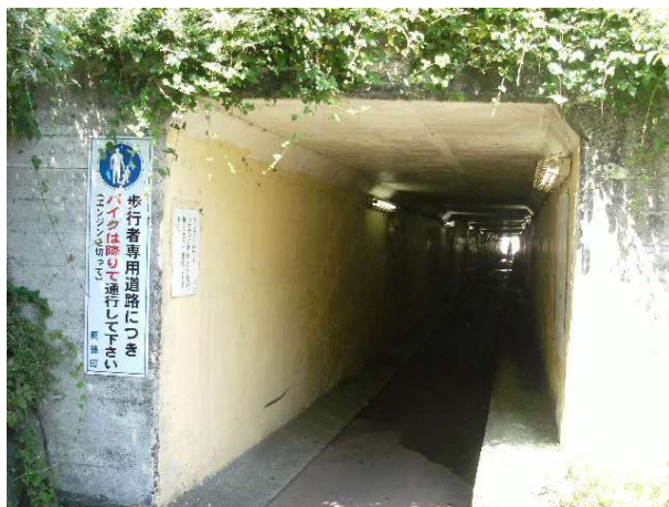
第2東前沢トンネル 起点(海側)
