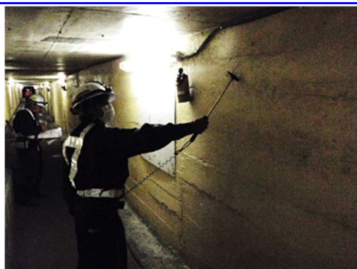
写真6－1 トンネル点検状況
