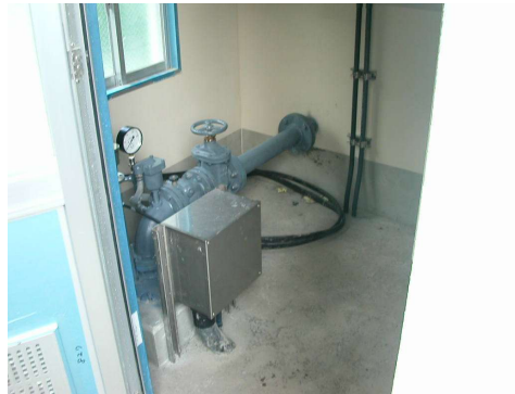
写真－6 柵子下水源取水ポンプ
