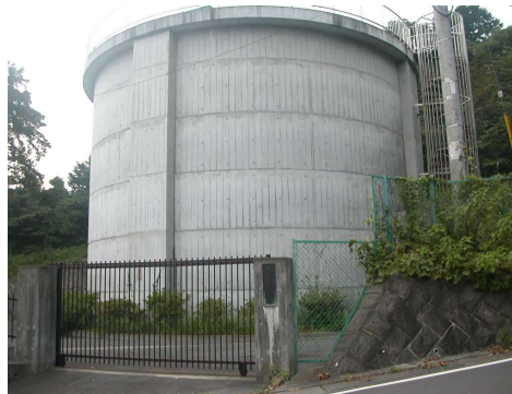
写真－2 大猿山浄水池
