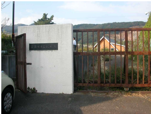
写真－7 用留配水池（1）
