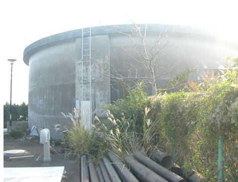
写真－8 用留配水池（2）
