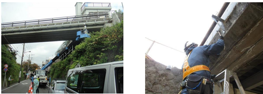
写真 6-1 橋りょう点検状況
