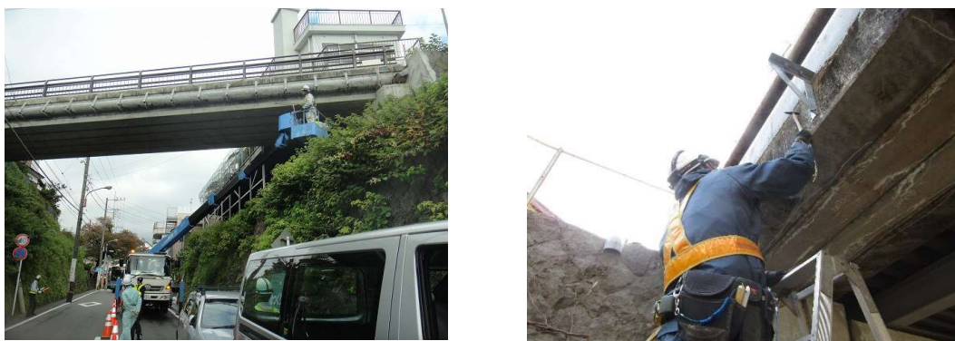
写真6-1 橋りょう点検状況
