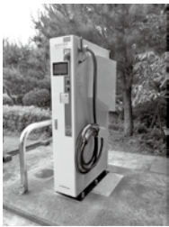
電気自動車用急速充電器
