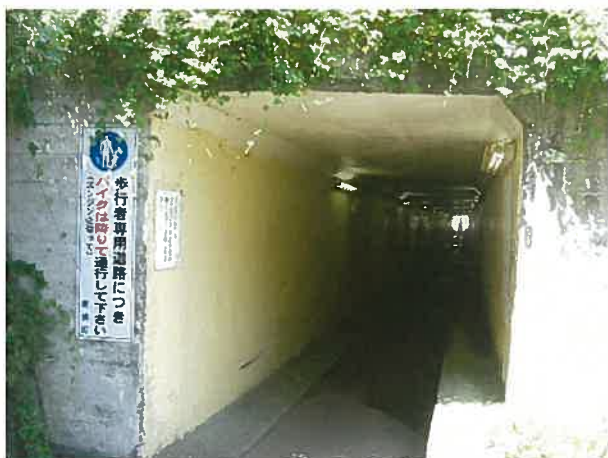
第2東前沢トンネル 起点(海側)
