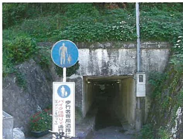
第2東前沢トンネル 終点(山側)
