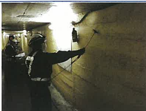
写真6-1 トンネル点検状況
