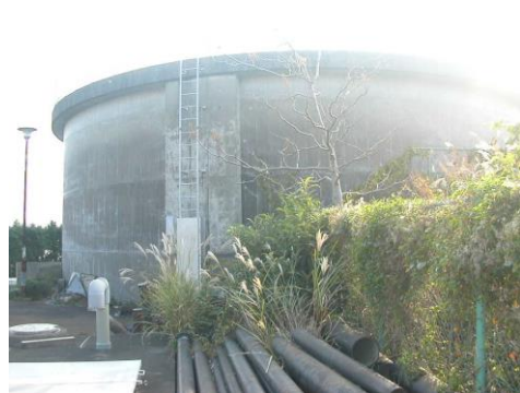
写真－8 用留配水池（2）
