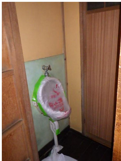
1 階トイレ（小便器）
