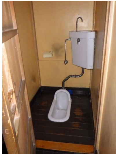
1 階トイレ（大便器）
