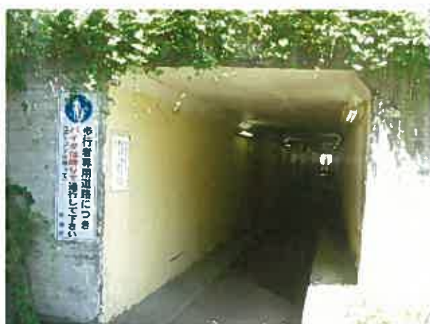
第2東前沢トンネル 起点(海側)
