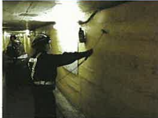
写真6-1 トンネル点検状況
