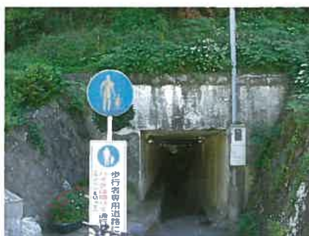
第2東前沢トンネル 終点(山側)
